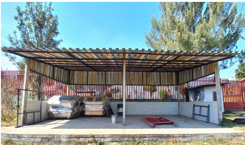
Imagen 6. Estación de transferencia techada.
